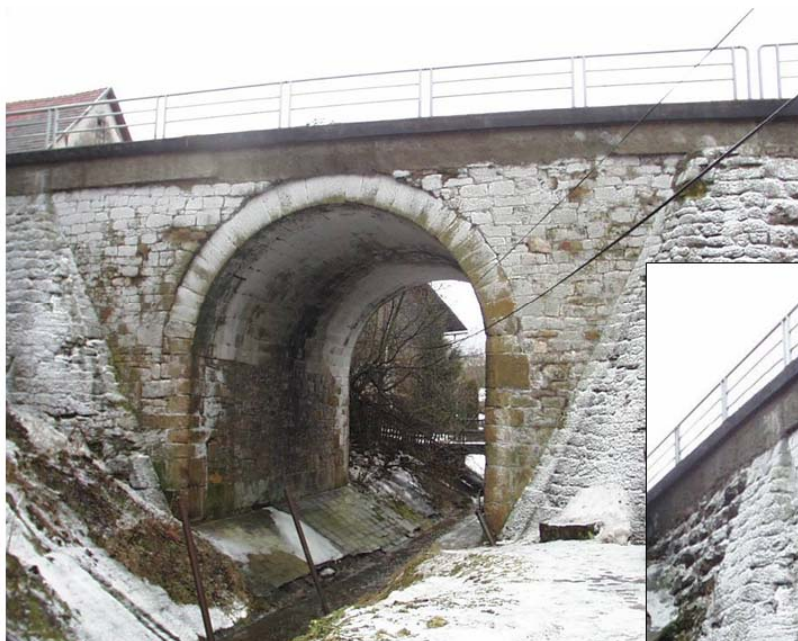
Most ev.č. 11-061 Rybná nad Zdobnicí, povodní strana
